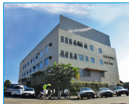
ELEVATEC Parque industrial de 5.000 m 2
